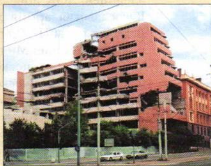
Разрушенное здание в Белграде
